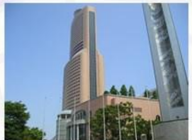
浜松アクトタワー カンファレンスセンター (アクトタワー 25階)
